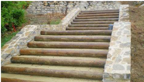
Escalier du parking Nord.
