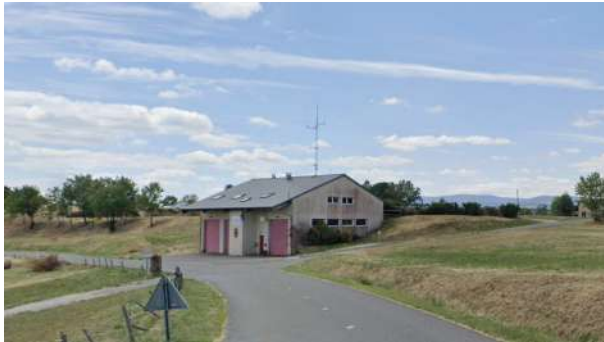
Départementale D13 existante
