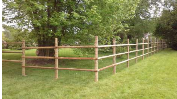
Clôtures du lotissement.
