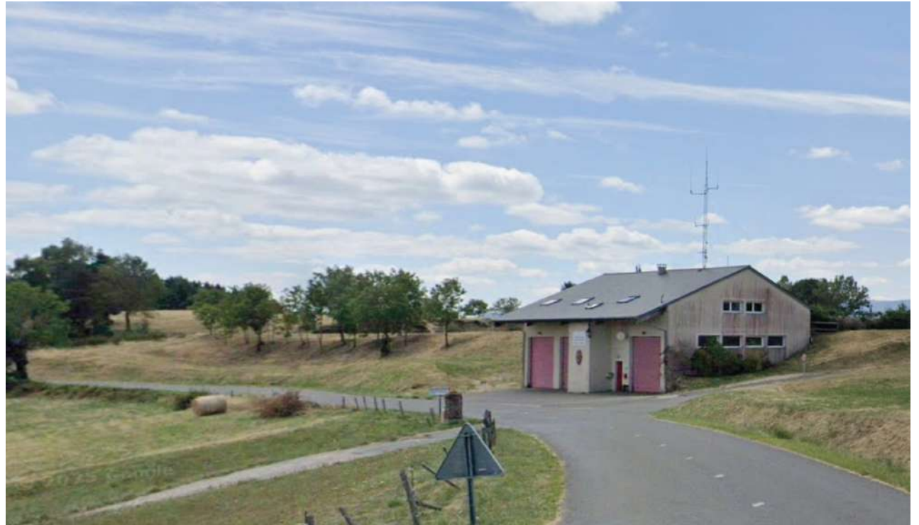
Vue sur l'entrée Nord Est du site d'intervention (C.I.S).
