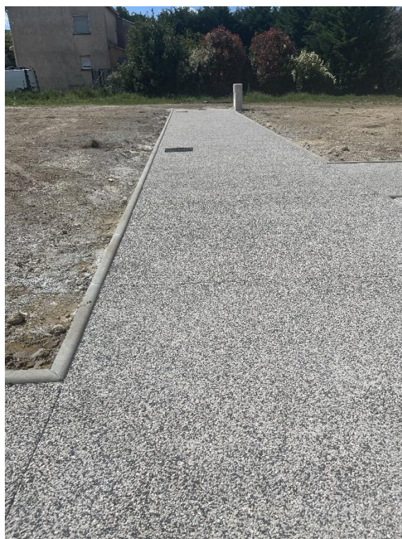
Figure 5 : exemple de béton drainant
