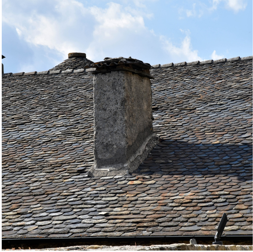
Les toitures en lauzes et les cheminées
