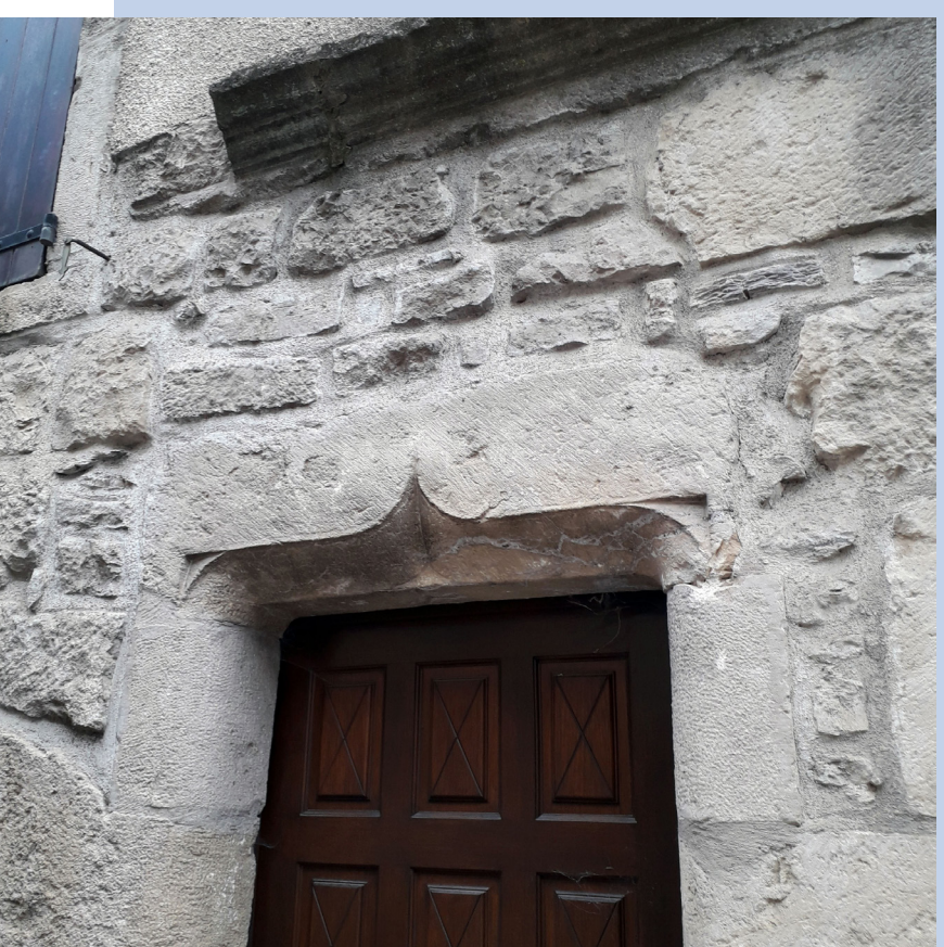
Linteau en accolade
