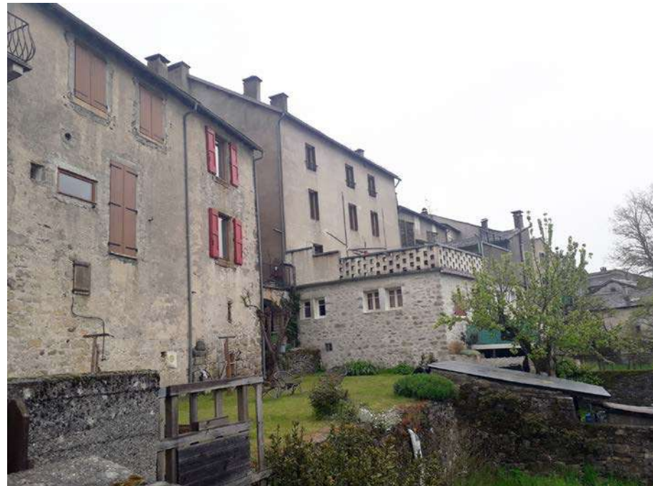
Rare soubassement encore fermé sur deux niveaux de sous-sol qui devait représenter le type de façade donnant sur l'extérieur du bourg et constituant l'enceinte fortifiée.
