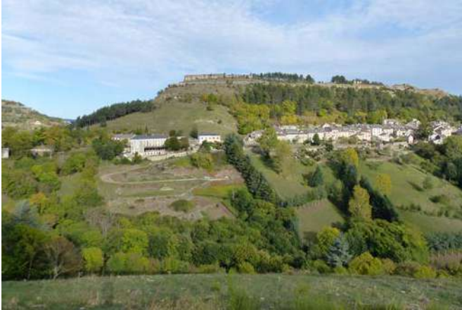
La STEP, son chemin d'accès en courbe et les déblais/remblais assez visibles sous la silhouette du village
