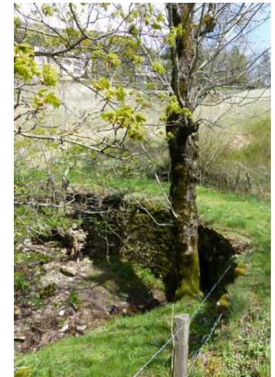
1. Ponceau sur le chemin muletier
