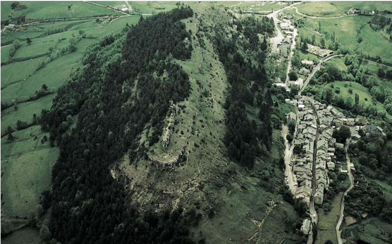
Vue aérienne du Castelas et du village de Barre-des-Cévennes - © Pierre Lahoud
