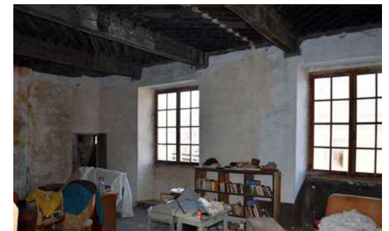
Pièce principale du premier étage
