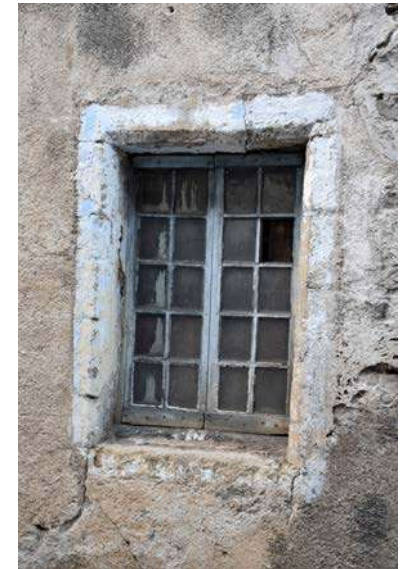
Fenêtre à petits carreaux
