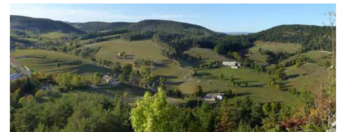
3. Vue depuis le Castelas sur la fenêtre paysagère de la plaine de Malzac
