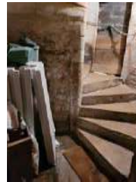
Escalier à vis
