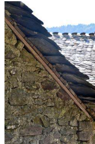
Toitures en lauzes
