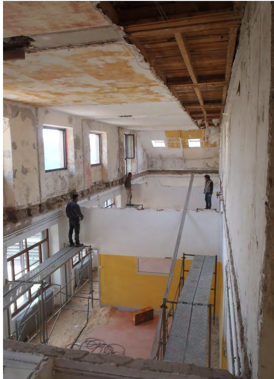
Achèvement de la première phase de démolition.
